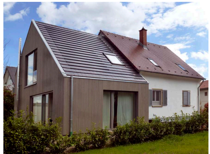
3 Solardachplatten belegen etwa die Fläche von 1 m 2 , Gewicht ca. 27 kg. 18 Solardachplatten ergeben eine PV-Leistung von ca. 1kW.
