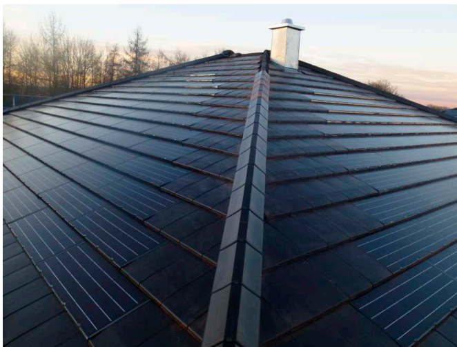
3 Solardachplatten belegen etwa die Fläche von 1 m 2 , Gewicht ca. 27 kg. 18 Solardachplatten ergeben eine PV-Leistung von ca. 1kW.
