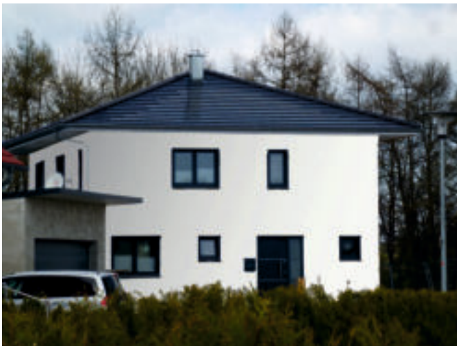
3 Solardachplatten belegen etwa die Fläche von 1 m 2 , Gewicht ca. 29 kg. Nennleistung von 14 Solardachplatten ca. 1,05 kW.
