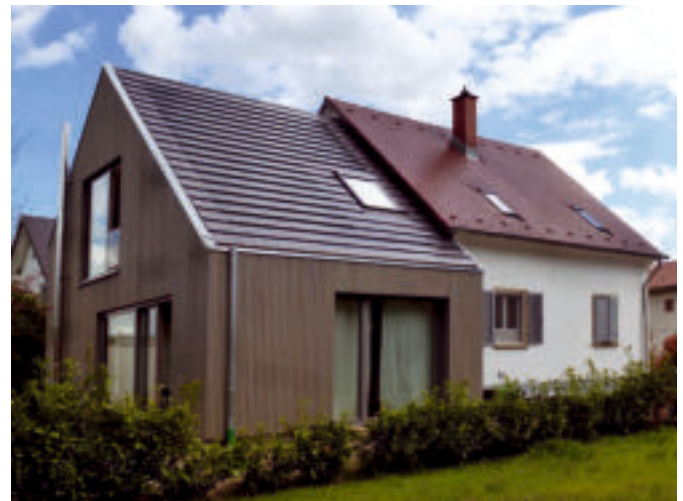
3 Solardachplatten belegen etwa die Fläche von 1 m 2 , Gewicht ca. 29 kg. Nennleistung von 14 Solardachplatten ca. 1,05 kW.
